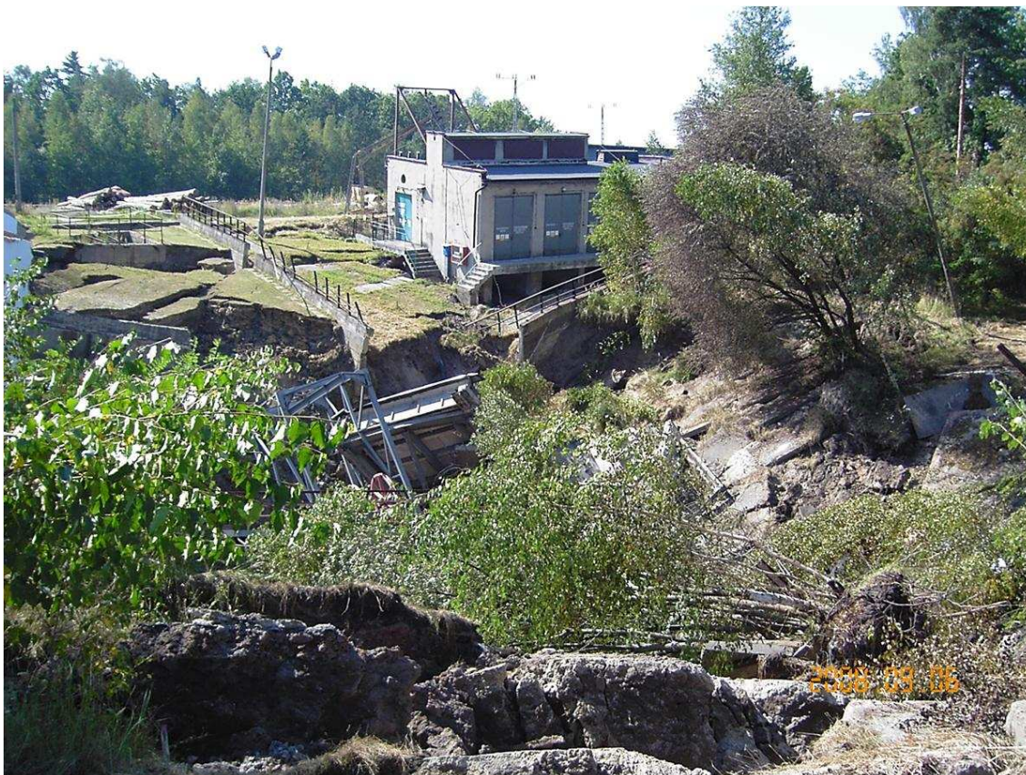
Fot. 1. Widok zapadliska w miejscu szybu
