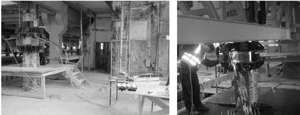
Rys. 5. Układ hydrauliczny dla słupa S70 i wycinanie słupa S61
