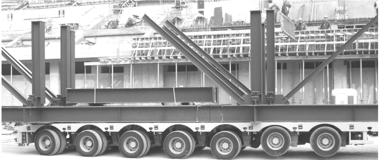
Rys. 6. Transport elementów wysyłkowych kratownic podłużnych rusztu dachowego
