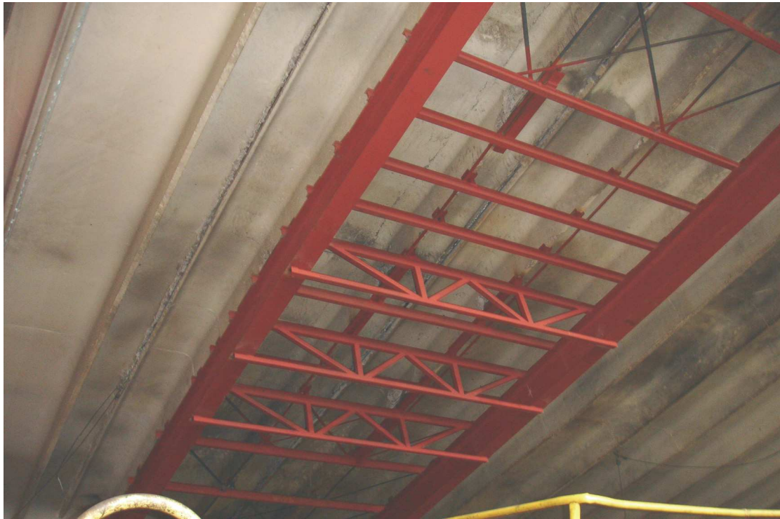
Rys. 6. Widok konstrukcji wzmacniającej uszkodzony dach hali
