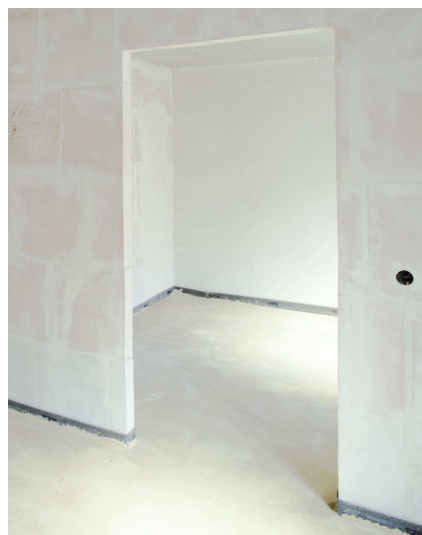
Rys. 5. Ściana z otworem drzwiowym wykonana z zastosowaniem zbrojenia progowego – widok po zakończeniu prac budowlanych
